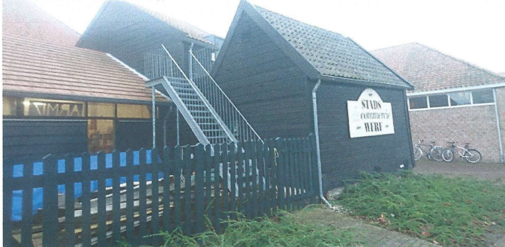
▲ De aanbouw van de Stads- en Commerciwerf in Zierikzee © Bouwbedrijf Quant
