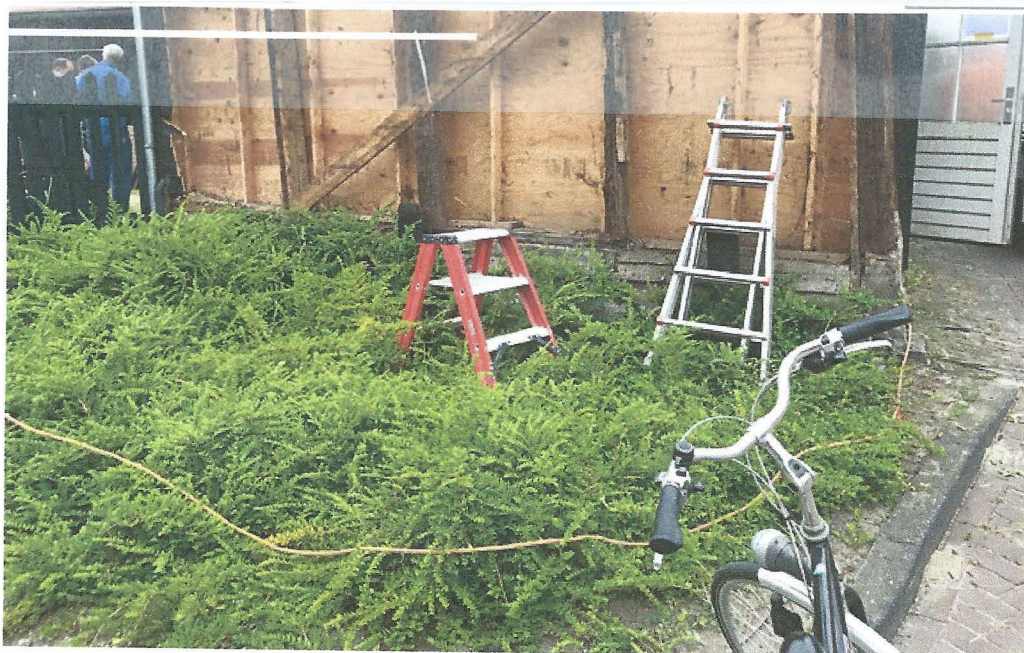
▲ De planken aan de buitenkant zijn vervangen. © Bouwbedrijf Quant
